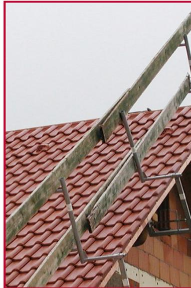
Das Layher Ortgang-Geländer (nach DIN EN 13374-A) - die Perfekte Absicherung des Ortgangs. In Kombination mit den unterschiedlichen Layher-Dachschutzwänden ist der Dacharbeitende im gesamten Dachbereich optimal vor Absturz gesichert.
