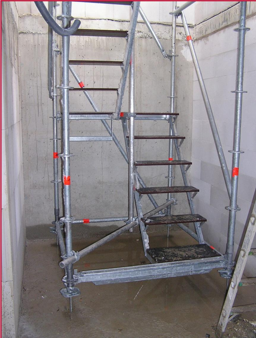
Gegenläufiger Aufbau auf Adapterplatten zur unbehinderten Estricheinbringung
